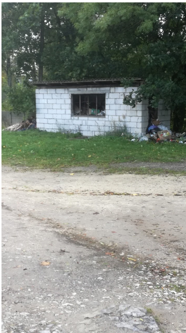
Budynek wagi – do rozbiórki
